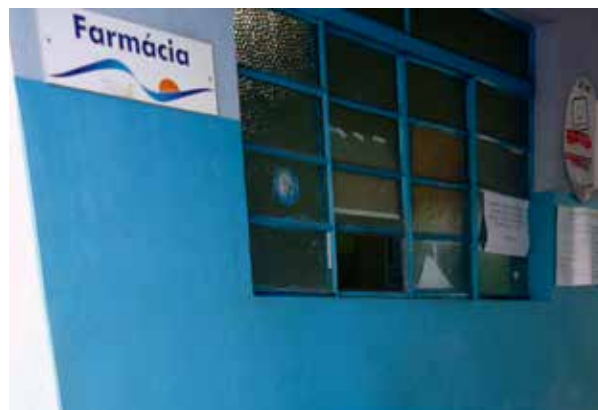
Em uma das farmácias, a dispensação era realizada por uma janela quebrada
