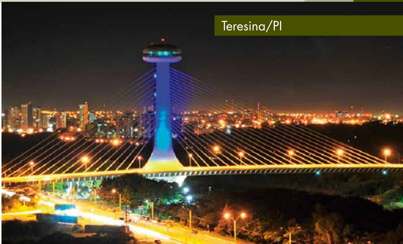
Ponte Estaiada Mestre Isidoro França, sobre o Rio Poti, Teresina (PI)
